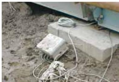
L'élimination des boîtes de jonction a supprimé la cause la plus commune des pannes sur un pont-bascule.
